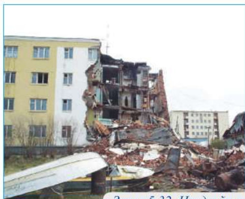
Зураг 5.32. Цэвдгийн гэсэлт нь байшин барилга нурах, хөрсний гулсалт үүсэх зэрэг олон сөрөг үр дагаварт хүргэж байна.
